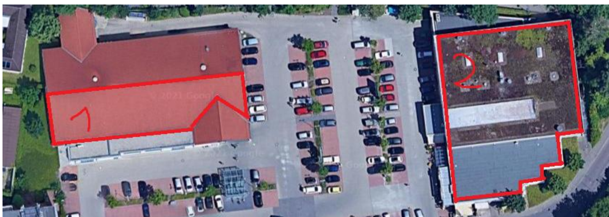
Abbildung 4: Dachflächen Quelle: www.google.com/maps
